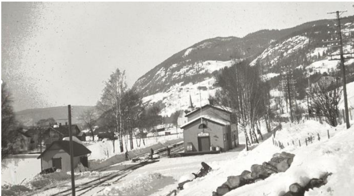
Figur 172. Stasjonsbygningen etter at det vart sett opp ny bygning i 1941. Foto: Gunder Kværne
