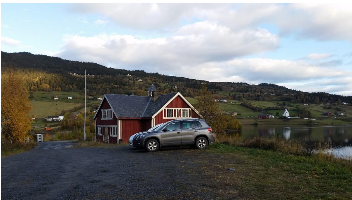
Figur 223. Ny parkeringsplass kom etter at vegen vart lagt om i 2003
