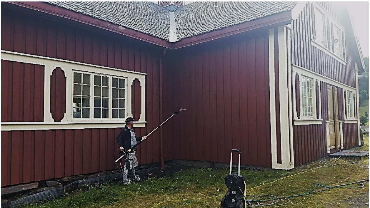
Figur 237. Utvendig vasking av huset hausten 2020
