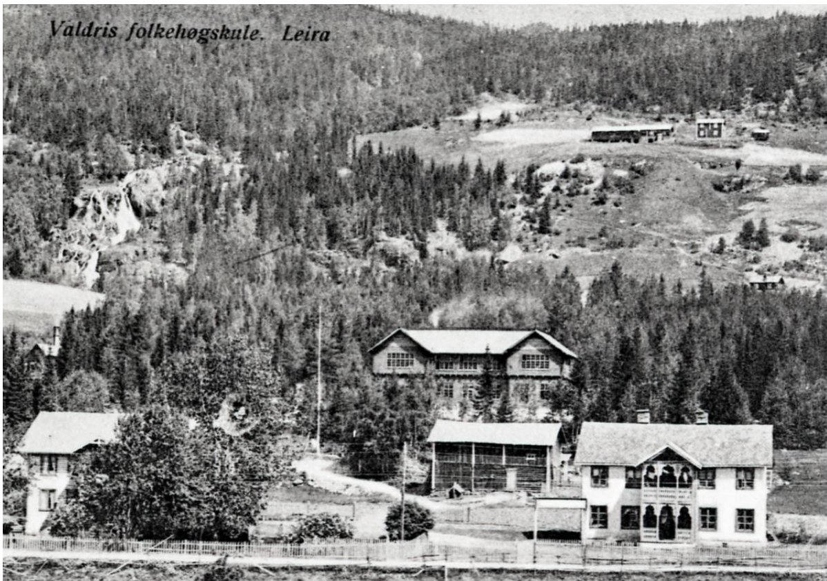
Figur 7. Dette postkortet viser den eldste bygningen på Valdres folkehøgskule frå 1912. Dette er truleg eit av dei eldste fotografia. Huset til venstre og huset til høgre vart bygd av Nils Leira. Huset til venstre (også kalla Bø-huset) vart bygd i 1885 og skal vere det eldste huset av den opphavlege busetnaden som står att i Leira sentrum. Foto: Ukjend / Valdresmusea
