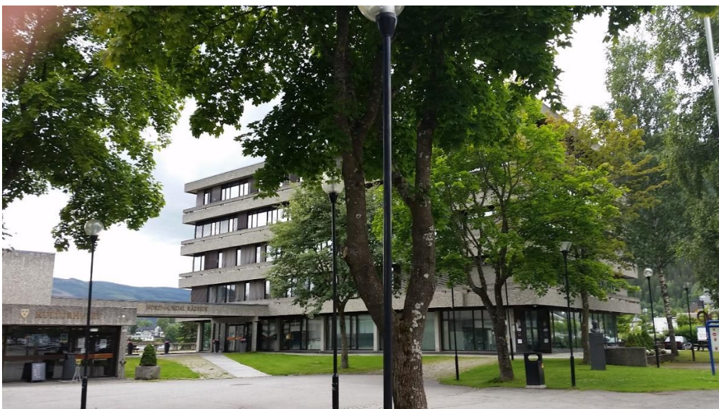
Figur 64. Rådhuset på Fagernes har ein modernistisk arkitektur. Arkitekten Bjart Faye Mohr har teikna fleire liknande bygningar rundt om i landet.
