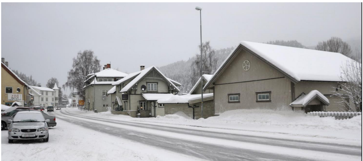
Figur 73. På bildet ser vi Bjerknes med rappeteknikk på høgre side av gata, og Strømsnes-villaen like framfor.
