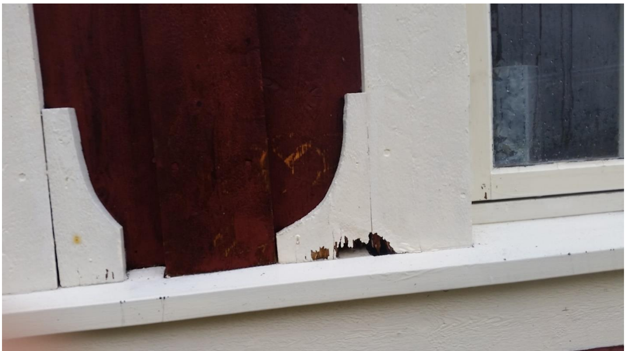
Figur 236. Røteskade ved vassbord
