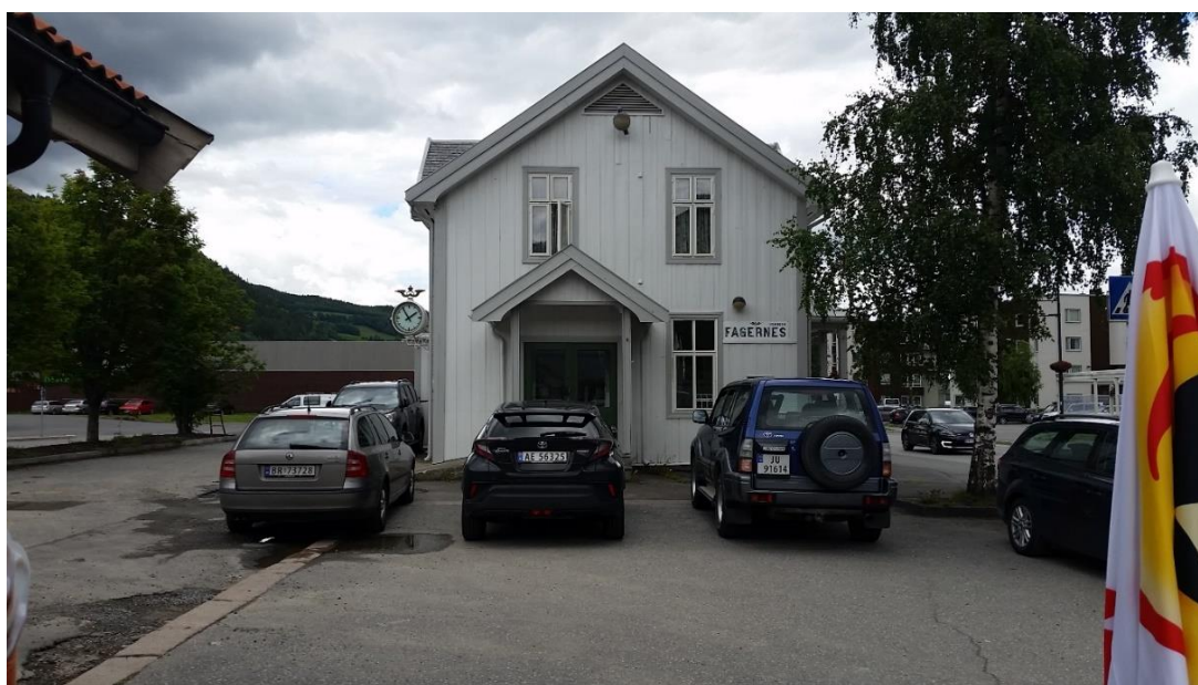
Figur 166. Stasjonsbygningen på Fagernes 2020
