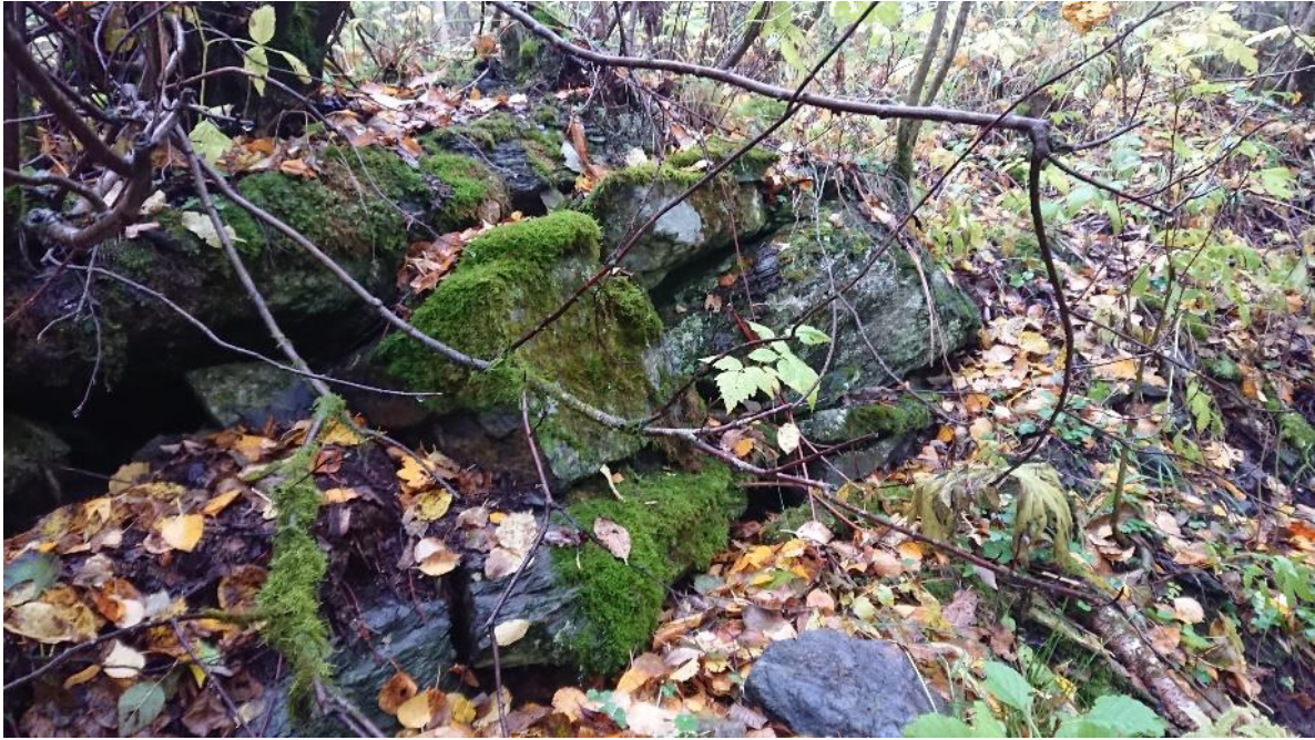
Figur 140. Mur på strekninga ved Nørre Ton. Foto: Nina Espeseth Grønbrekk
