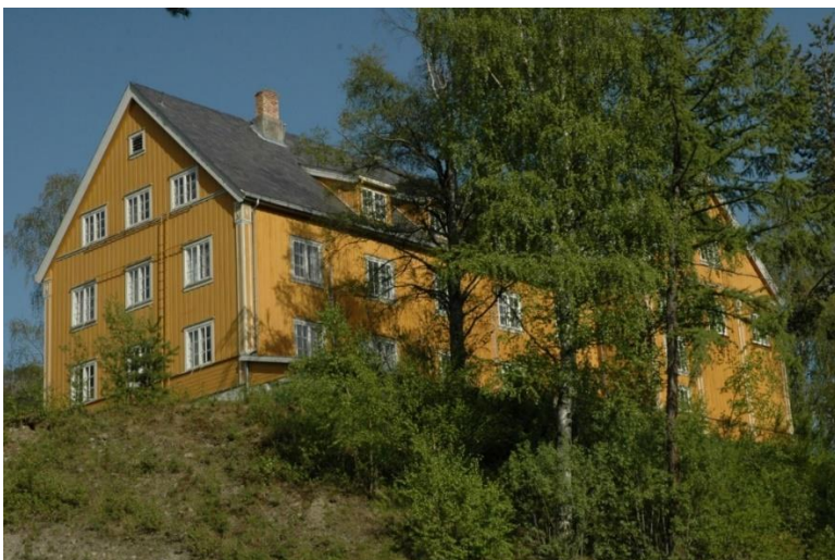
Figur 12. Gulbygningen vart i 2007 overdregen frå Oppland fylkeskommune til Stiftelsen Gulbygningen på Måno. Stiftelsen har rehabilitert bygningen og fekk i 2010 tilskot til dette frå Kulturminnefondet
