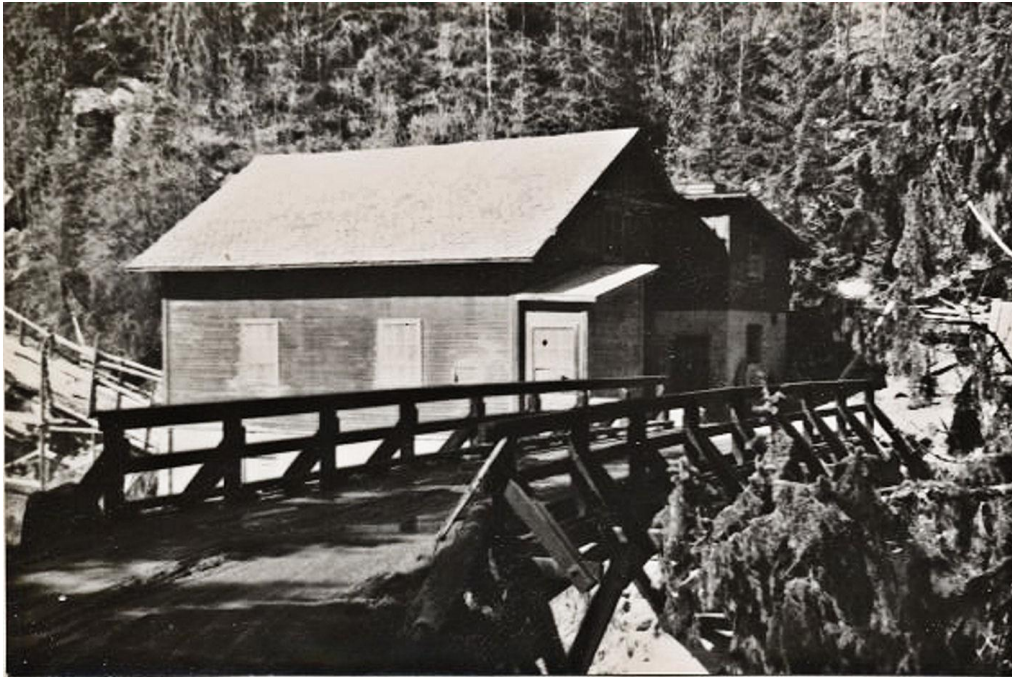
Figur 210. Til venstre på fotografiet ser ein brua over inntaksrøyret til vassturbinen. Foto: Ukjend
