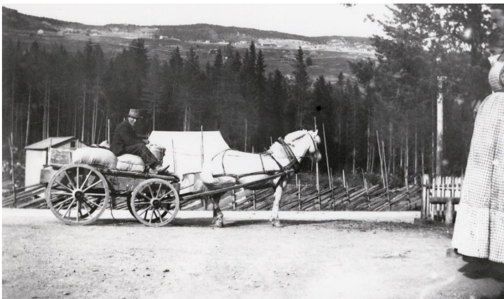
Figur 137. Den gamle veggen mellom Aurdal og Leira. Foto: Ola Gudheim / Valdresmusea AS
