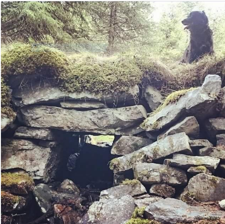
Figur. Til venstre: Stikkrenne ovanfor Tonsåslinna. Til høgre: Strekninga Bjørgo – Nørre Ton er i relativt god stand. Foto: Nina Espeseth Grønbrekk
