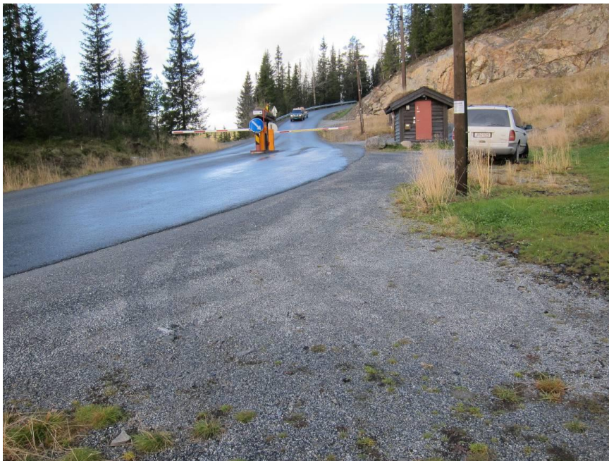
Danebuvegen mot Freningvegen, ved bommen
