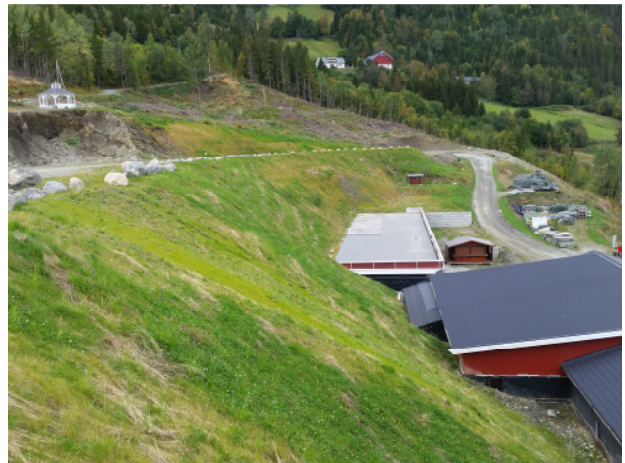
Skråningen mellom øvre og nedre nivå
