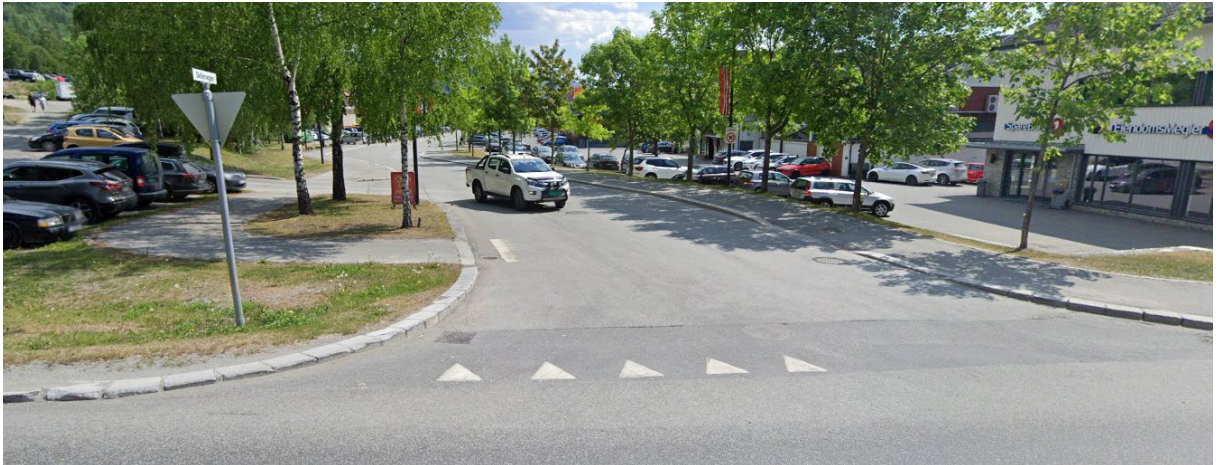
Dagens situasjon for Skifervegen x E16, hvor det nesten er plass til et høyresvingefelt. Justering av kantsteinene vil gi plass til et høyresvingefelt.
