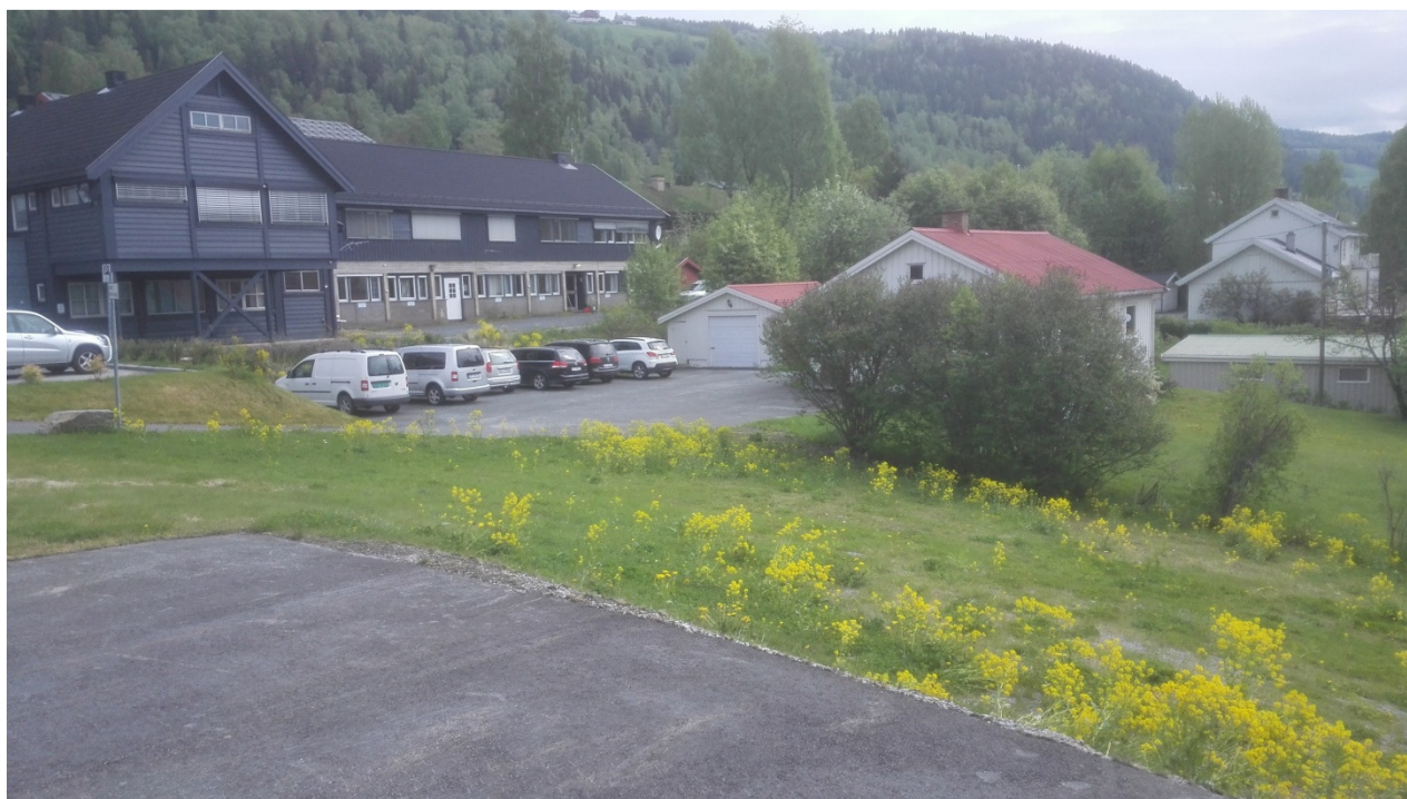
Eksisterende bolig (m. rødt tak) skal erstattes av ambulansestasjon. Fagernes legesenter til venstre.
