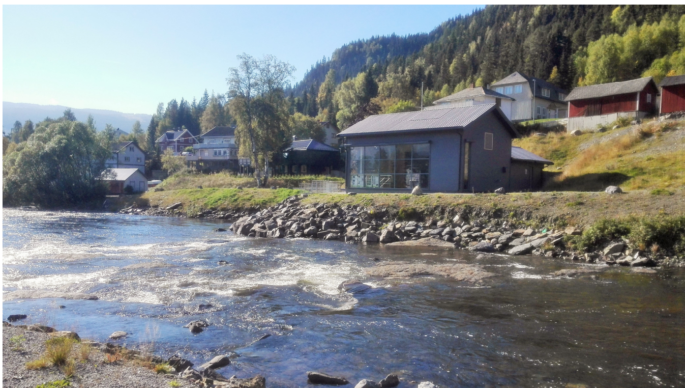
Kvitvella Electricitetsverk sett fra østsiden av Neselva. Planområdet omfatter også de fire boligene mellom Bygginvegen og Neselva.
