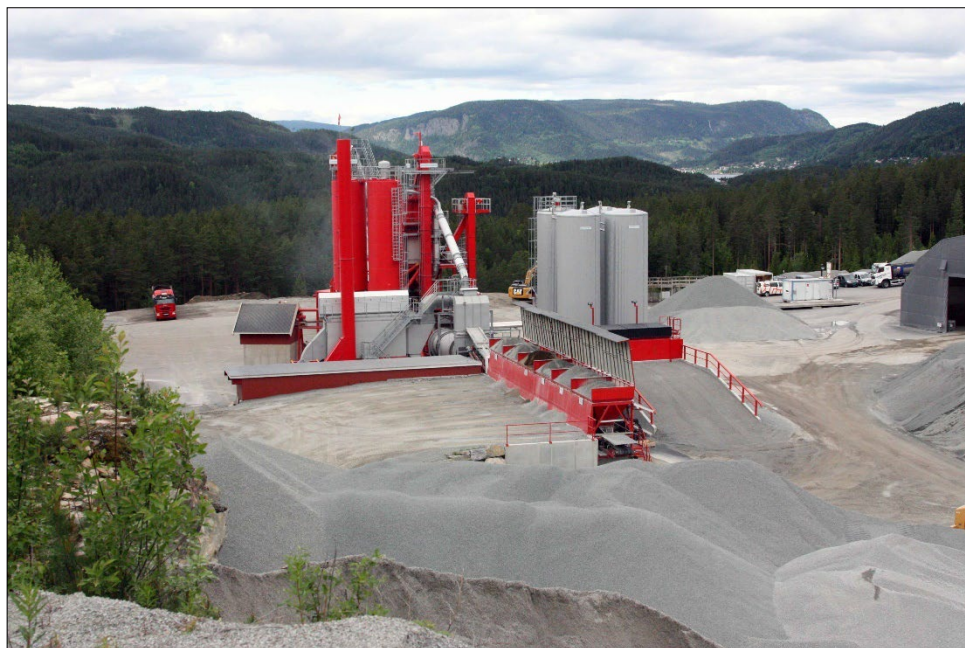
Figur 3-5: Asfaltverket fotografert 14.06.2017. Fagernes skimtes i bakgrunnen.
