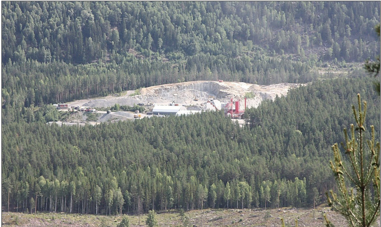
Figur 3-3: Kalplassen fjelltak zoomet bilde tatt fra vest mot øst. Kontorbrakkene til venstre, asfaltverket i røde farger t.h., to plasthaller i forgrunnen i bruddet. Fotografert i 2018.
