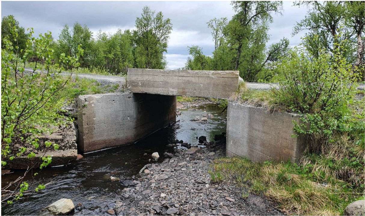
Figur 7: Innløpet til brua under Skørvestølvegen.
