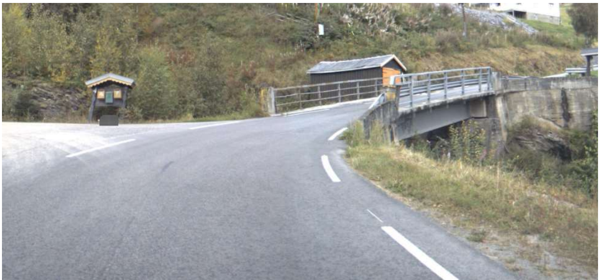
Bildene viser brua med nærområdet.
