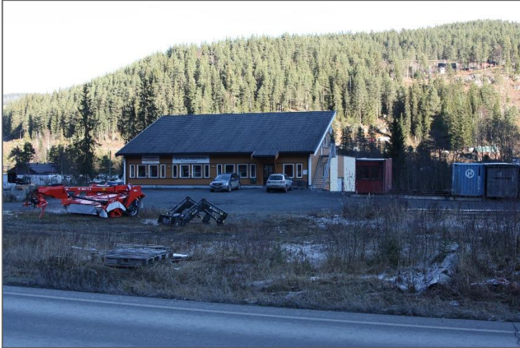
Næringsbygg på eiendom gnr. 71 bnr. 15 sett fra fv. 51.
