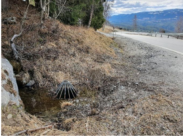
Figur 3: Stikkrenne A under Danebuvegen.
