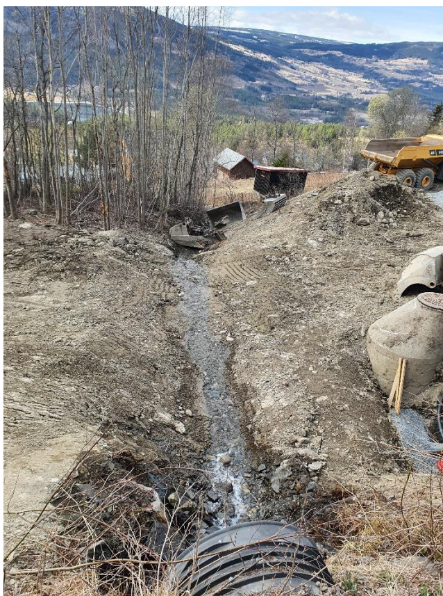
Figur 11: Rudsbekkens nye bekkeløp nedstrøms Fautrudvegen.
