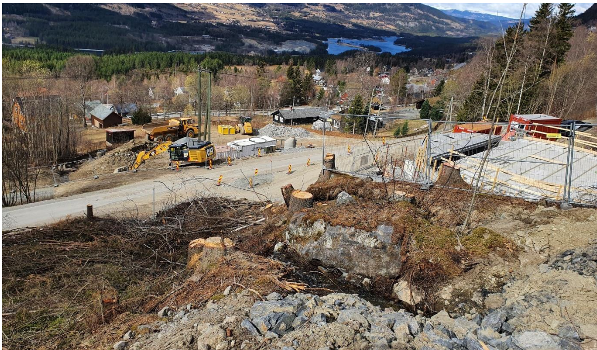
Figur 10: Høydebasseng til høyre og planert område for maskiner på nedsiden av Fautrudvegen
