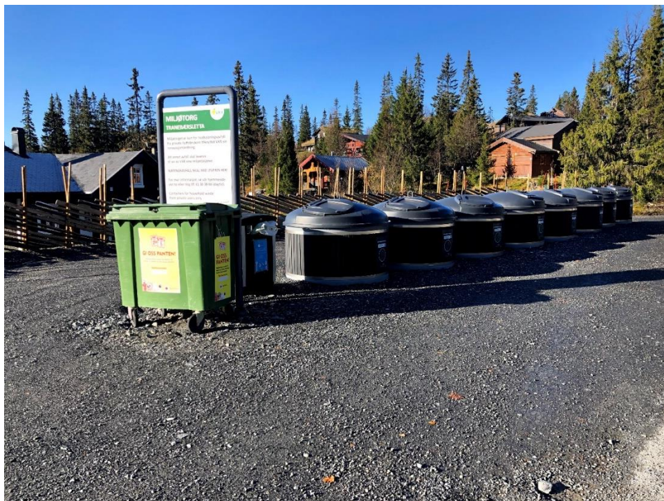
Renovasjonspunkt ved Ravangsvegen
