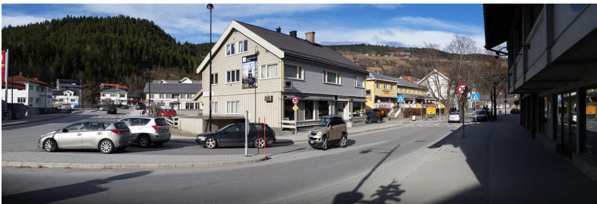
Situasjonen i krysset Valdresvegen - Jernbanevegen
