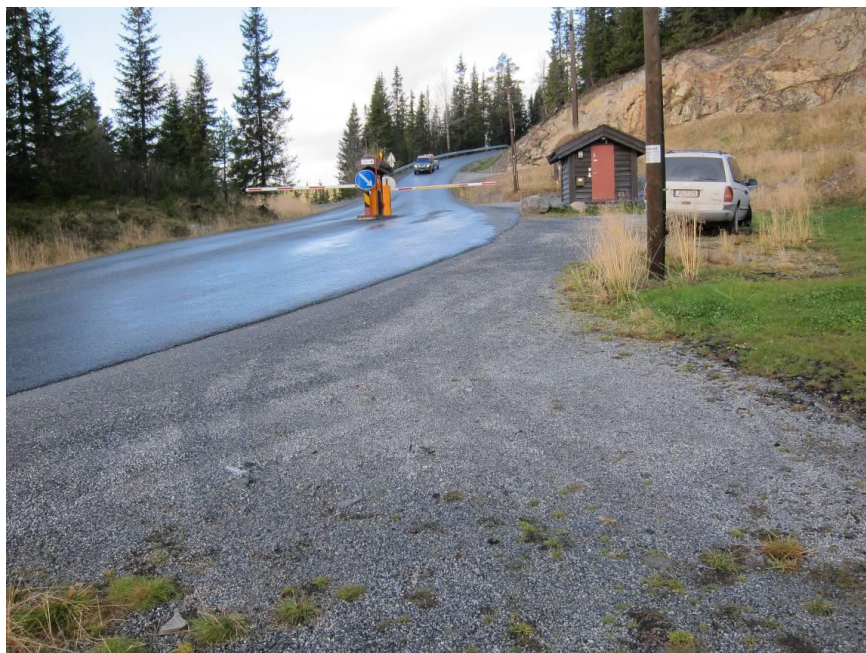
Danebuvegen mot Freningvegen, ved bommen
