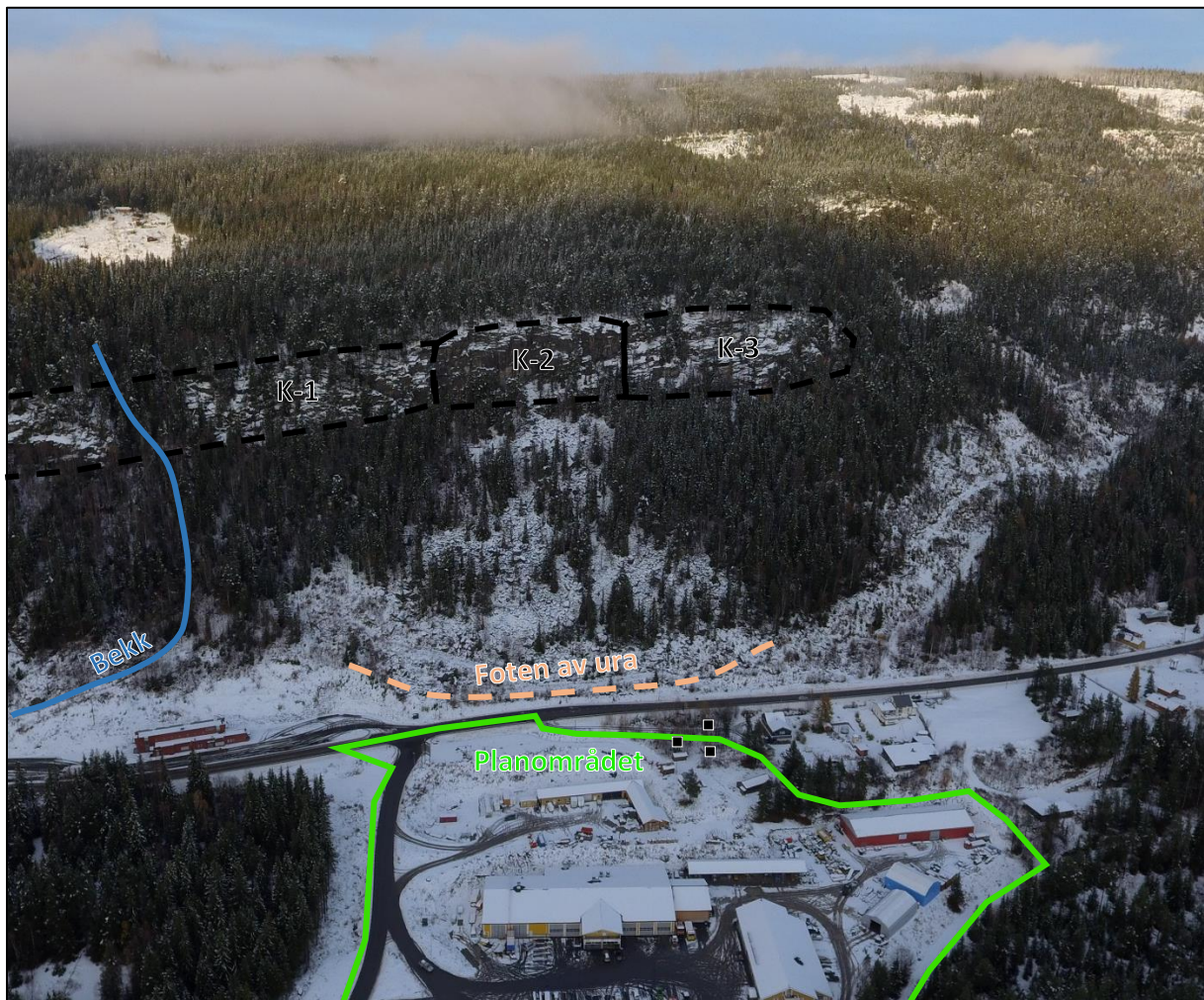
Figur 7: Oversiktsbilde av potensielle kildeområder for steinsprang, K-1 til K-3. Viser også foten av ura, steinsprangblokker (svarte firkanter) utenfor foten av ura, planområdet og bekken ved Statens vegvesens vektstasjon. Bilde er tatt mot nordøst.
